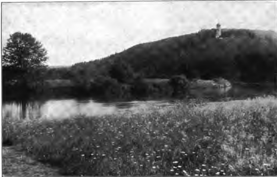
Fig. 31. Heilbrünnl. Ansicht der Wallfahrtskirche.
